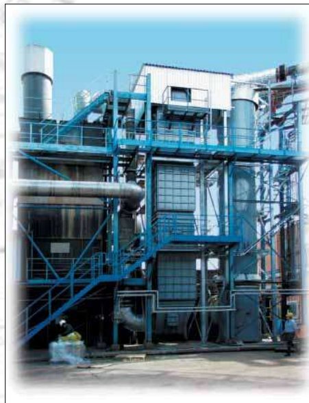
Kupolókemence füstgáztisztító berendezések
